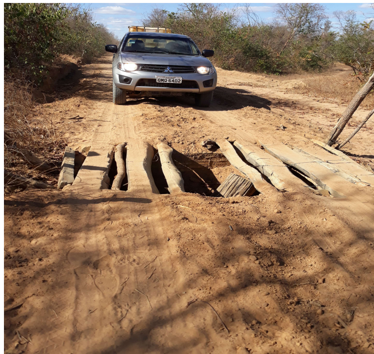
Figura 19 e 20: Mata-Burro Estrada São Romão a Capim Branco.
