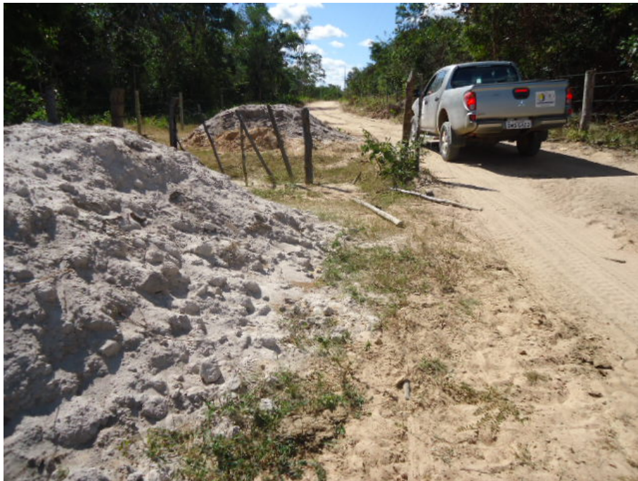
Figura 16: Mata-Burro Comunidade Escuro (Srº Nelo Calado). Coordenadas: S16°25'54.3 - W45°16'56.8
