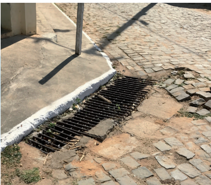
Figura 60 – Bocas de Lobo Inadequadas Fonte: GESOIS, 2017
