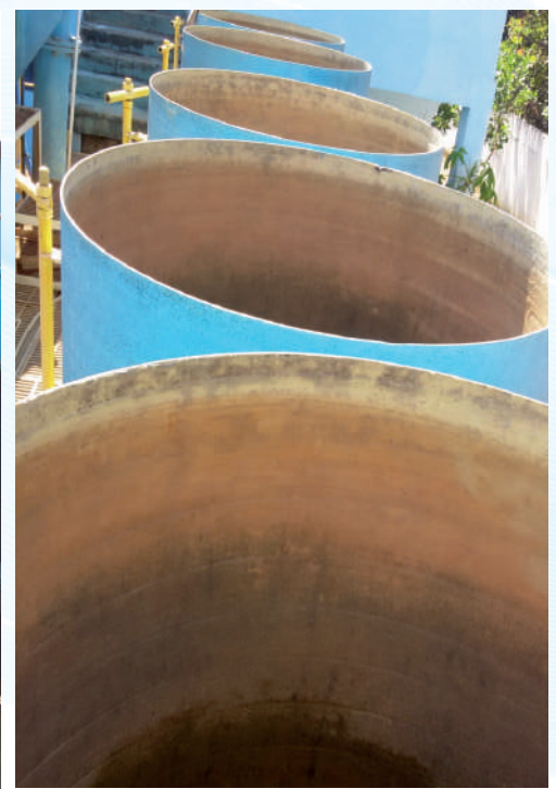
Figura 35 – Decantador de Água Fonte: GESOIS, 2017
