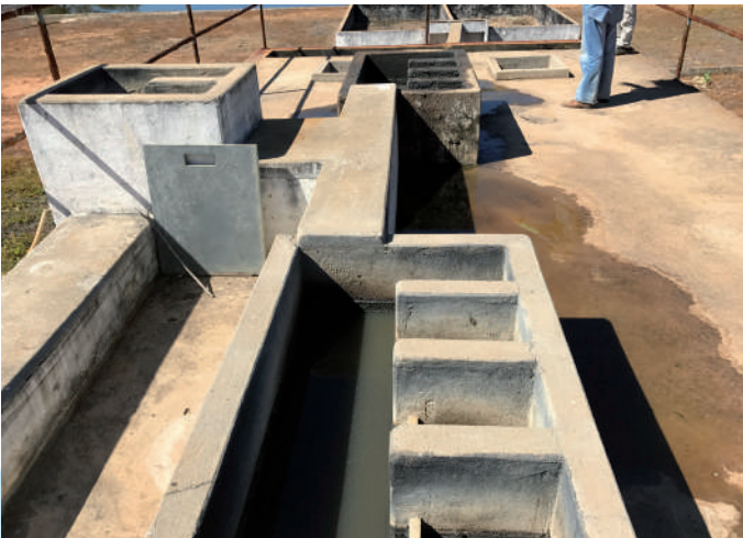
Figura 43 – Reator UASB e Leitos de Secagem em São Romão
