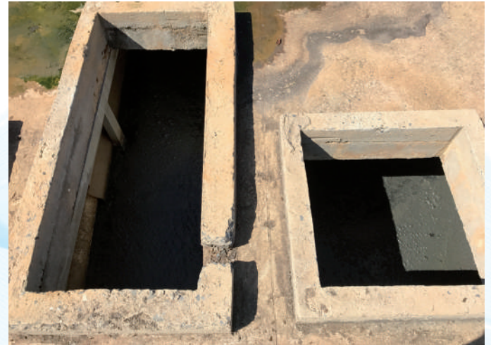
Figura 43 – Reator UASB e Leitos de Secagem em São Romão
