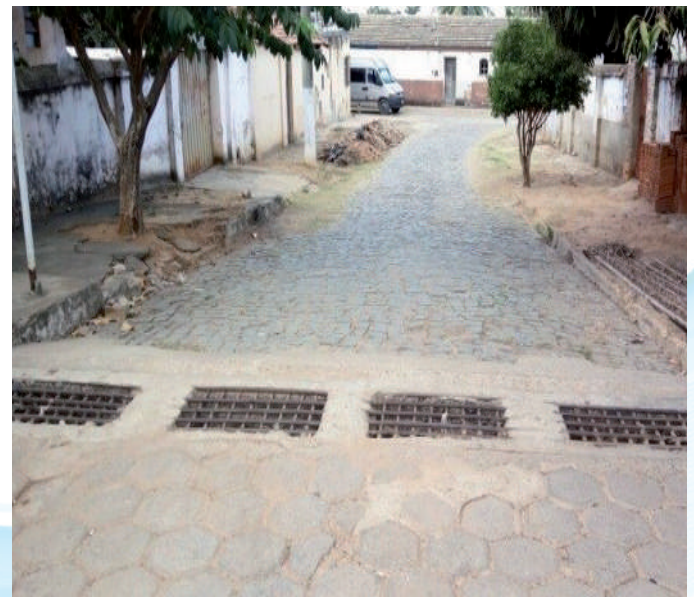
Figura 60 – Bocas de Lobo Inadequadas Fonte: GESOIS, 2017
