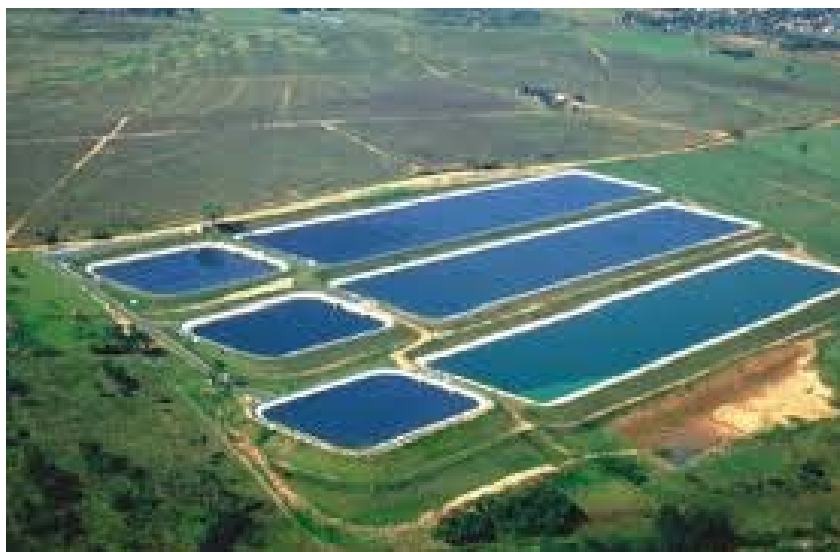
Figura 31 – Lagoas de Estabilização Fonte: USP, 2014
