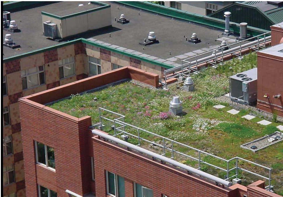
Figura 65 – Telhado Reservatório / Telhado Verde Fonte: PORTLAND, 2002
