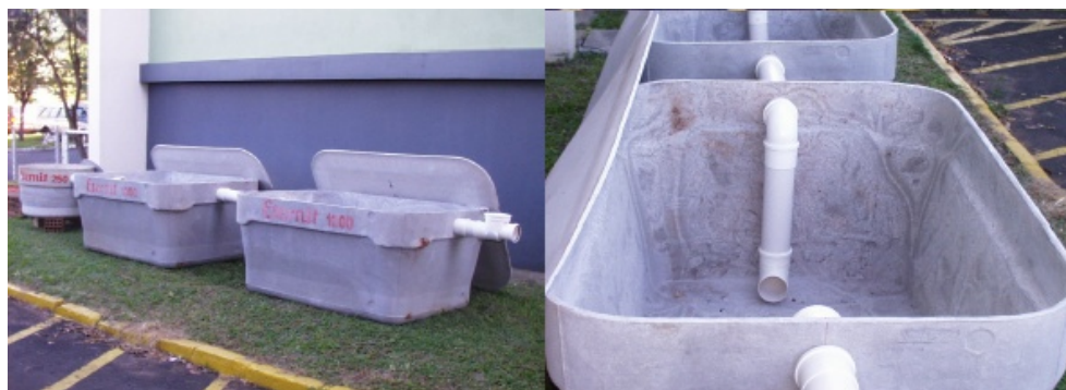
Figura 33 – Biodigester Montado: Vista Lateral e Vista Superior Fonte: EMBRAPA, 2010
