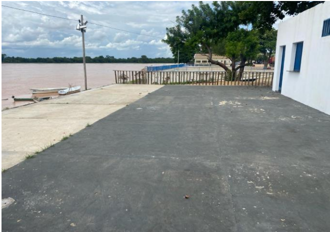
Localização da fotografia PRAÇA DA ORLA FOTO 13 Data da fotografia 05/04/2024
